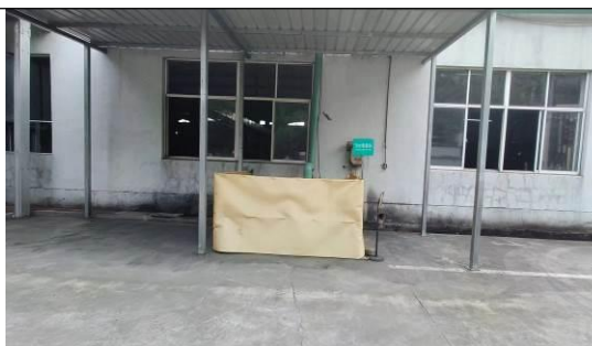
线绳车间外西侧污水收集池
